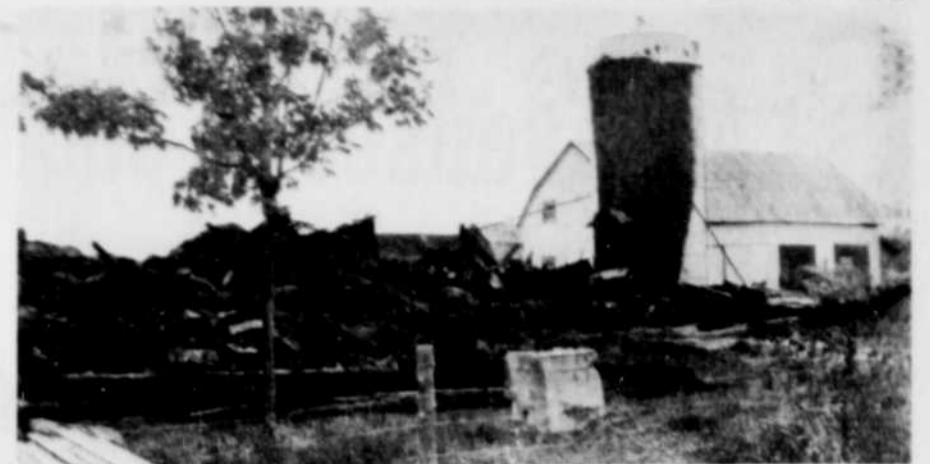
A la suite de l'incendie qui a ravagé la ferme de M. Aimé Guilbert hier matin à St-André d'Acton, il ne restait plus que des ruines et des pertes matérielles estimées à environ 200.000 $.
