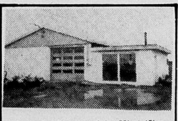
ST-ANACLET , édifice 31' x 59' et 15' x 32'16', peut servir pour garage pour mécanique générale ou tous autres services, construction 1977. Consultez Denise Gendreau 724-6130, 722-7695.
