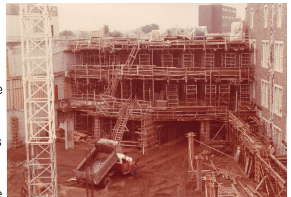
Construction de l'entrée principale du Cégep de Saint-Jérôme (455, rue Fournier).
