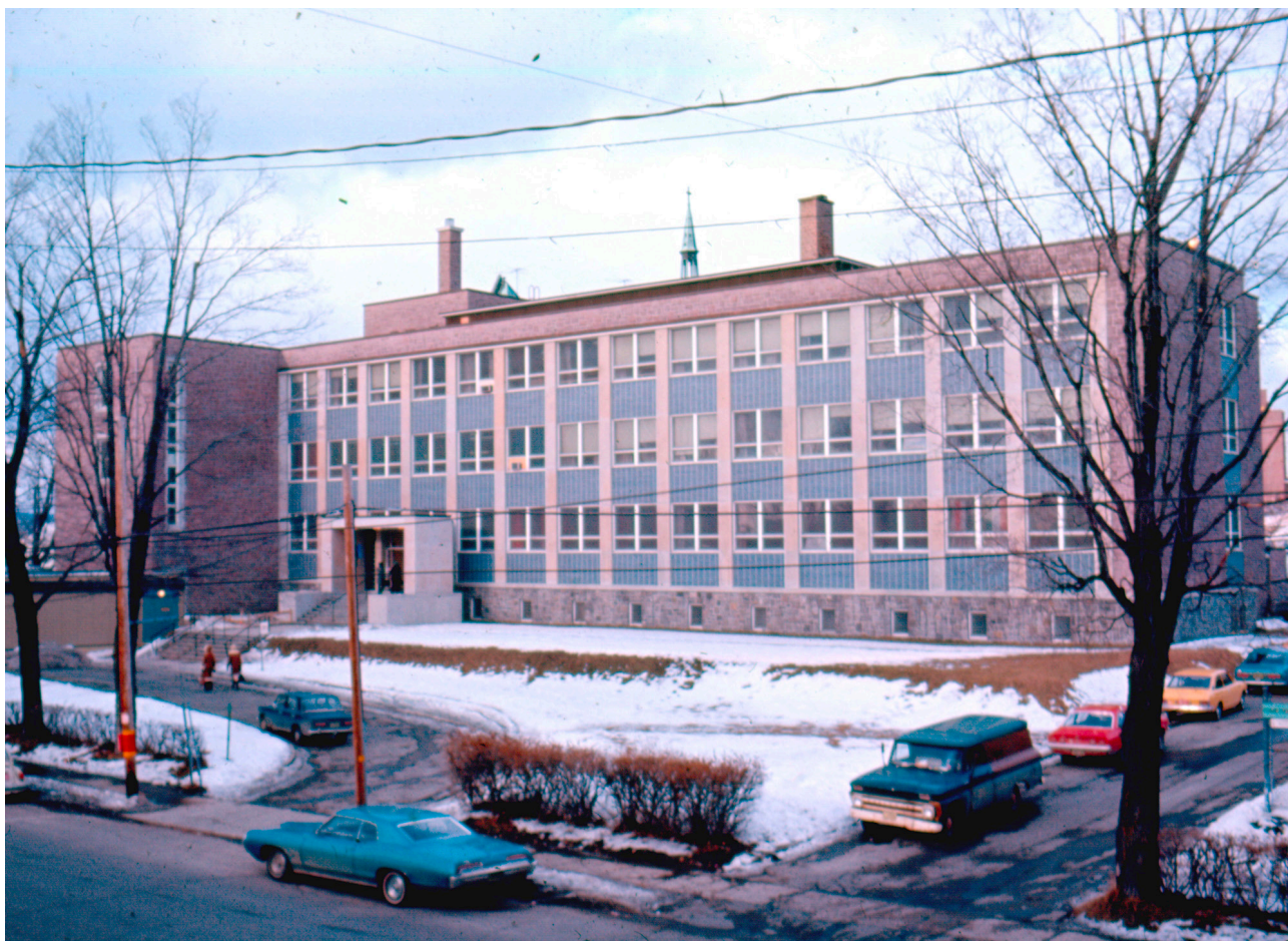
Le Cégep vu de la rue du Palais, où se trouvait l'entrée principale avant les grands travaux du milieu des années 1970. Source : Cégep de Saint-Jérôme
