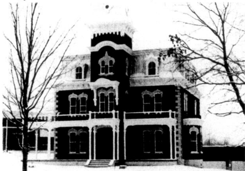
La Maison Cormier qui devrait, un jour, abriter les employés du module social du CLSC de l'Erable.
