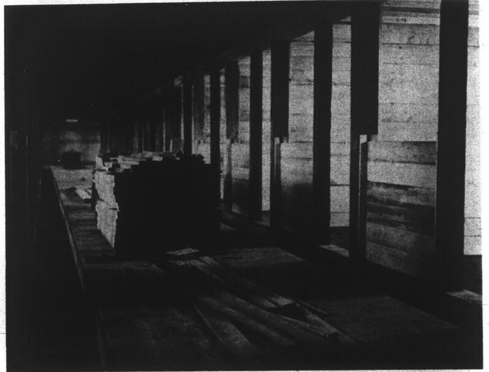
Au rez-de-chaussée, un aperçu des stalles qui abriteront les chevaux.
