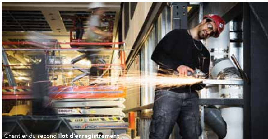
Chantier du second îlot d'enregistrement
