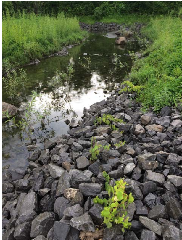
Photo 8. Exemple de plantation de saule dans le perré directement dans l'eau à l'aide de sac de plantation (Source : Steve Hamel)
