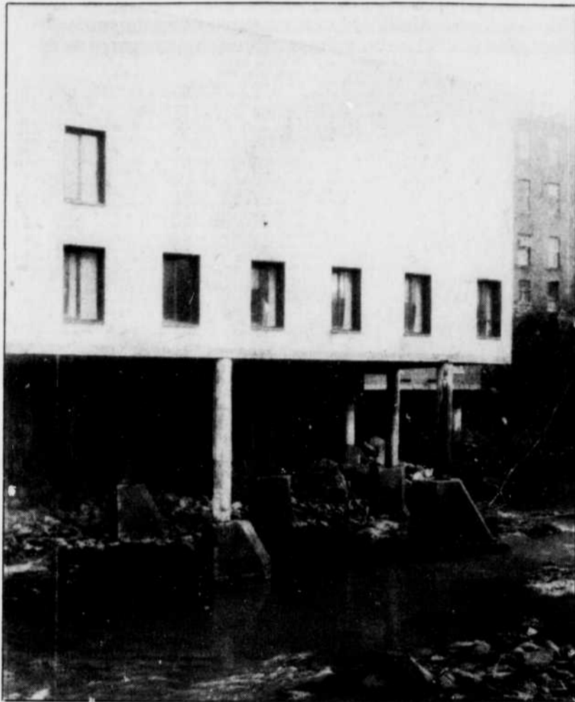
L'édifice Gabr, dont les piliers reposent continuellement dans l'eau, devrait faire l'objet de vérifications constantes, a indiqué hier l'ingénieur Fouad Victor.
