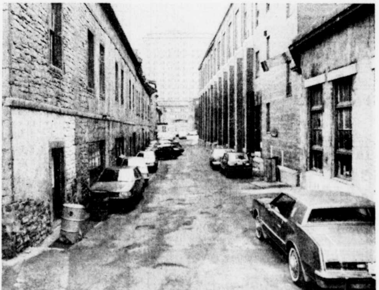
En plus d'être en rupture violente avec l'environnement bâti, la tour de 14 étages de l'Hôtel-Dieu de Québec est à l'origine de l'un des plus tragiques problèmes de stationnement du Vieux-Québec.
