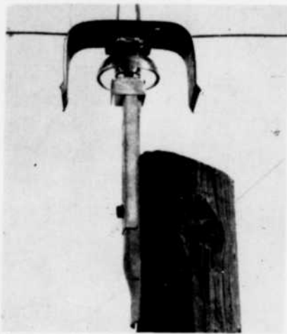
Fig. 3 — Déioniseur monté sur isolateur Kimble 13.8 KV (Centres Phases).
