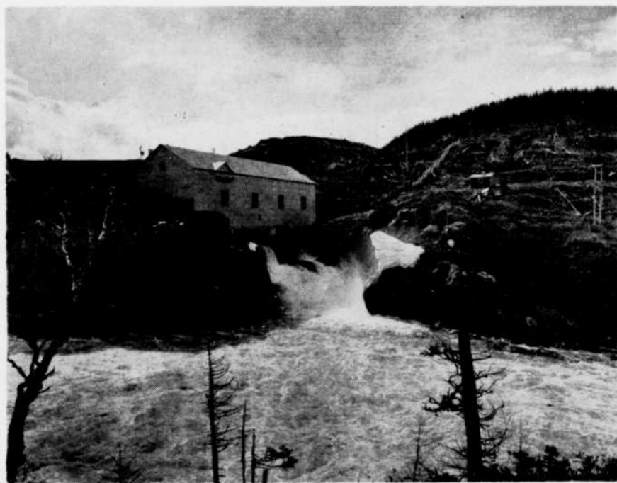
Fig. 10 — La centrale provisoire au Lac Cassé, montrant l'eau s'écoulant en cascades des tubes d'aspiration.
