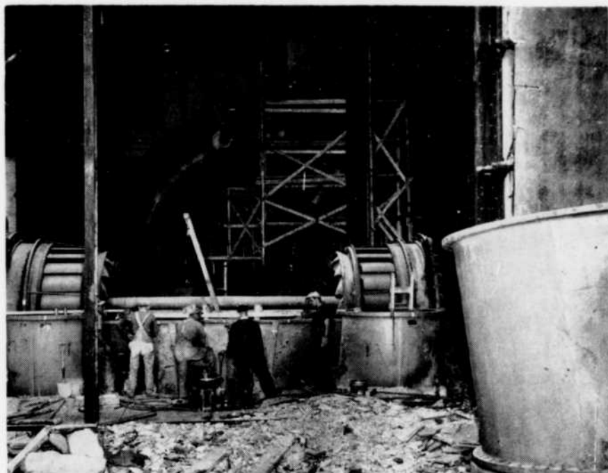
Fig. 5 — Démontage d'une turbine dans la centrale de Saint-Timothée (Photo Canadian Ingersoll Rand).
