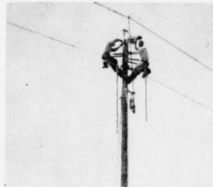
Fig. 4 — Montage d'un Déioniseur sur isolateur Kimble 13.8 KV à Sanford, N.C.
