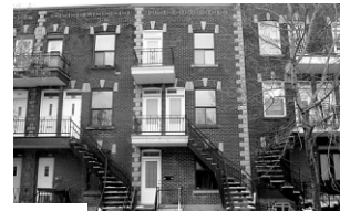
1436 Appartements rénovés, 1 chambre planchers bois franc, balcons, cour
