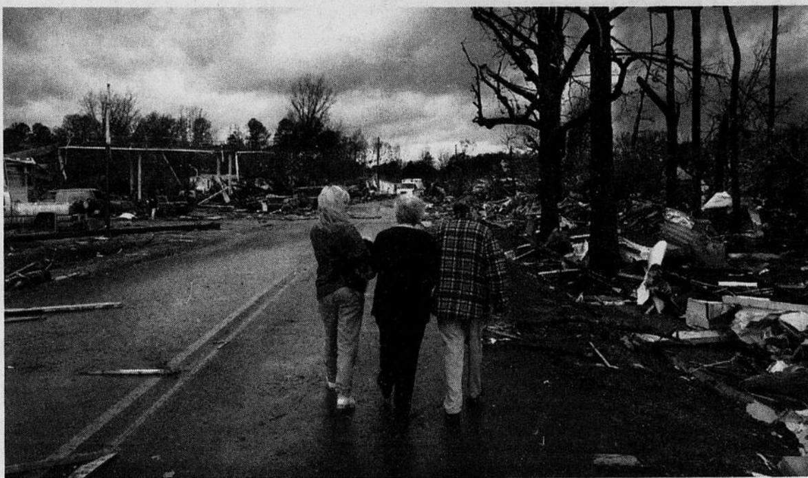
Des résidents du chemin Bear Creek ne peuvent que constater les dégâts causés par les tornades, samedi, à Tuscaloosa, en Alabama, où au moins 12 personnes ont été tuées.
