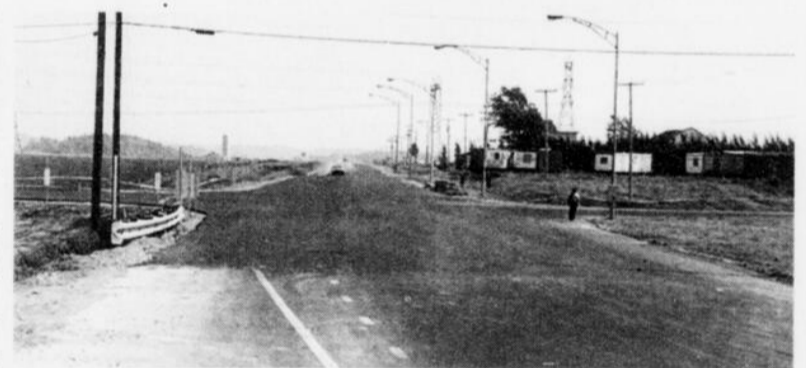
ROUTE- Les automobilistes peuvent depuis une semaine emprunter la route habituelle, soit la 170 à la hauteur de St-Bruno. Un immense gouffre s'était creusé, lors des fortes pluies du 20 juillet, arrachant l'intersection du rang six et l'entrée principale conduisant à Traisa-Sol, en face.
