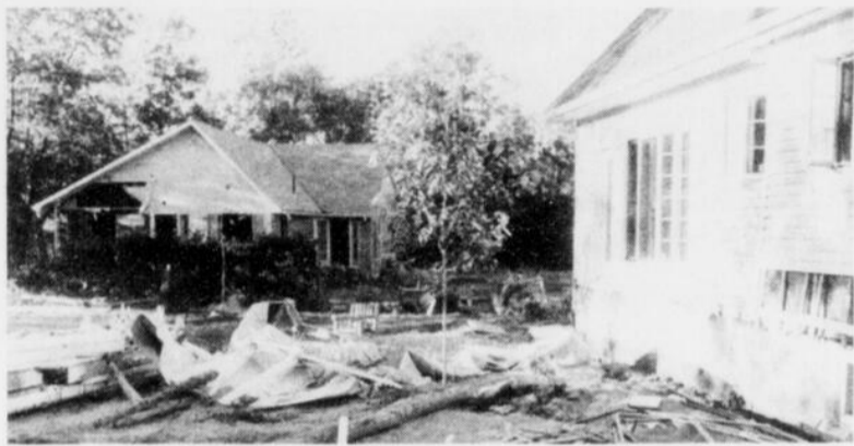
DESTRUCTION D'UN REVE - Bertrand Pilote des Battures Saint-Paul a vu le rêve de sa vie être réduit à néant avec le passage de la crue des eaux. Sa maison est celle de gauche et, à droite, celle de son beau-frère. Dans ce secteur de Laterrière, c'est la désolation la plus complète.
