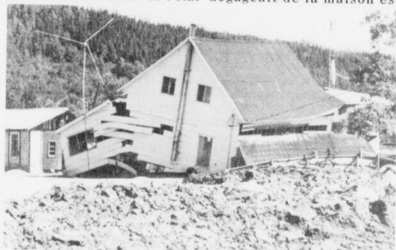
LA FIN - L'une des plus vieilles maisons de Boilleau sera inévitablement démolie. L'effet du courant a désarticulé la structure de la construction.
