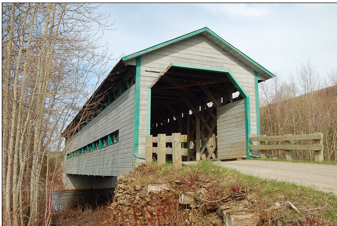
Pont de la Neigette, Saint-Anaclet
