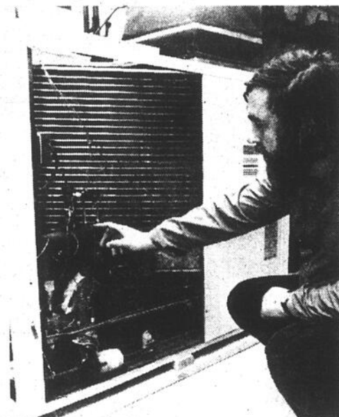
Réjean Boucher explique le fonctionnement d'une pompe à chaleur ou thermopompe qui agit comme un réfrigérateur ou un climatiseur... mais à l'envers.
