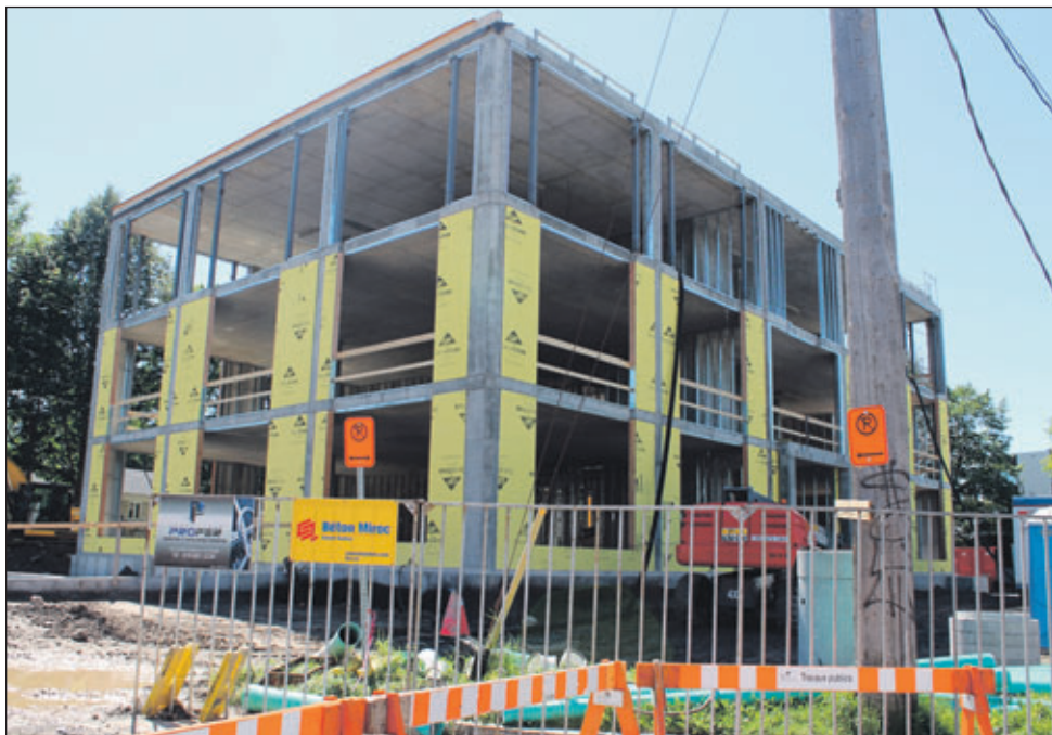
L'édifice Gescorp, en cours de construction.
