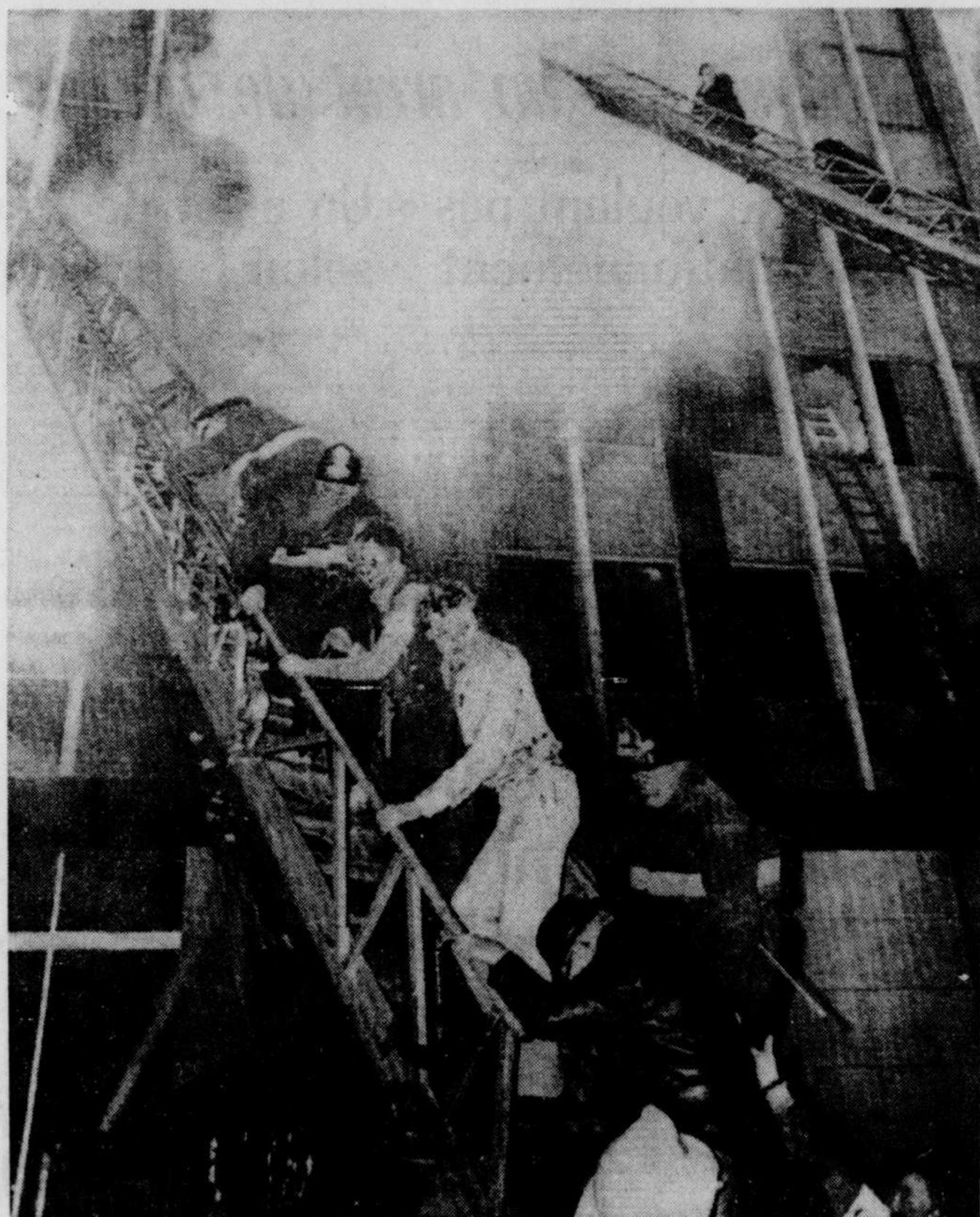
Les employés travaillant dans l'édifice de l'Air Liquide à Montréal, ont dû être évacués avec l'aide des pompiers, à la suite d'un incendie de cinq étages qui a dévasté le bâtiment et fait au moins quatre morts. Plusieurs autres personnes ont été brûlées ou intoxiquées par les flammes et l'épaisse fumée qui avait envahi les bureaux. (Téléphoto PC)
