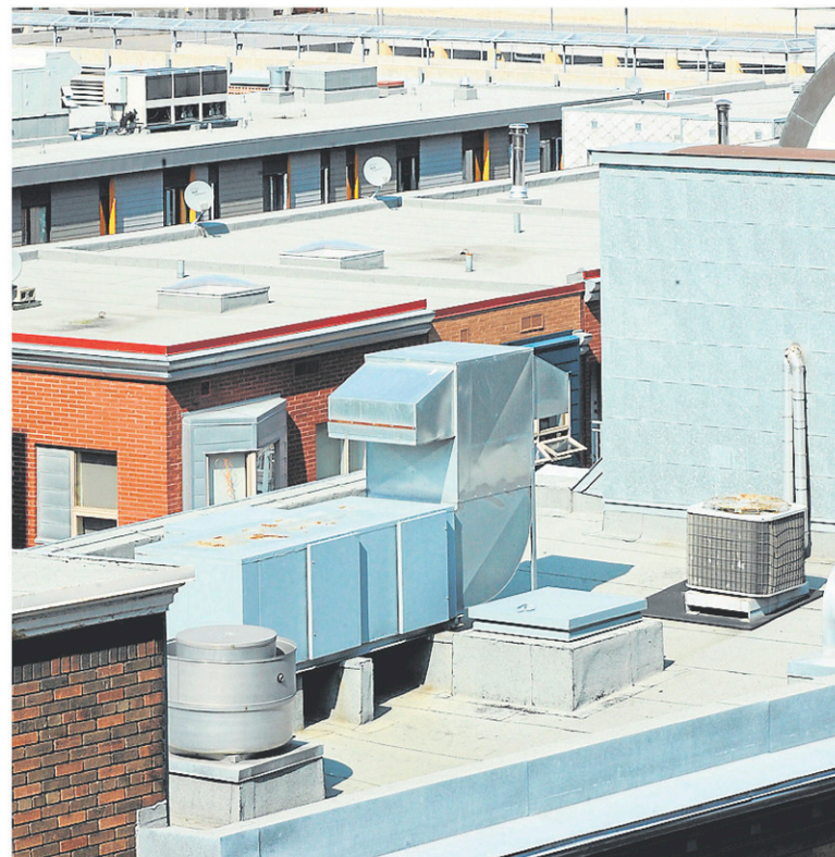
La légionellose s'attrape en respirant des microgouttelettes d'eau contaminées par la bactérie Legionella, qui sont en suspension dans l'air. Les tours de refroidissement peuvent notamment être en cause. — PHOTO ARCHIVES, LE SOLEIL
