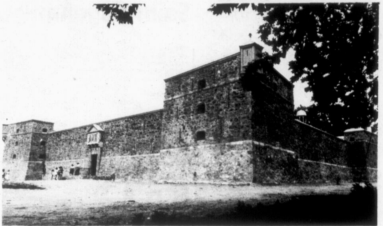
Au fort Chambly les travaux de restauration sont maintenant terminés. (Photo François Ménillo)
