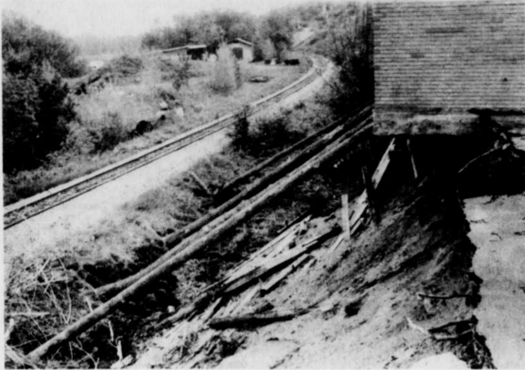
Même si on démolira la bâtisse, on a opté pour un encadrement sûr lors de ces opérations en assurant la pose d'arcs-boutants.
