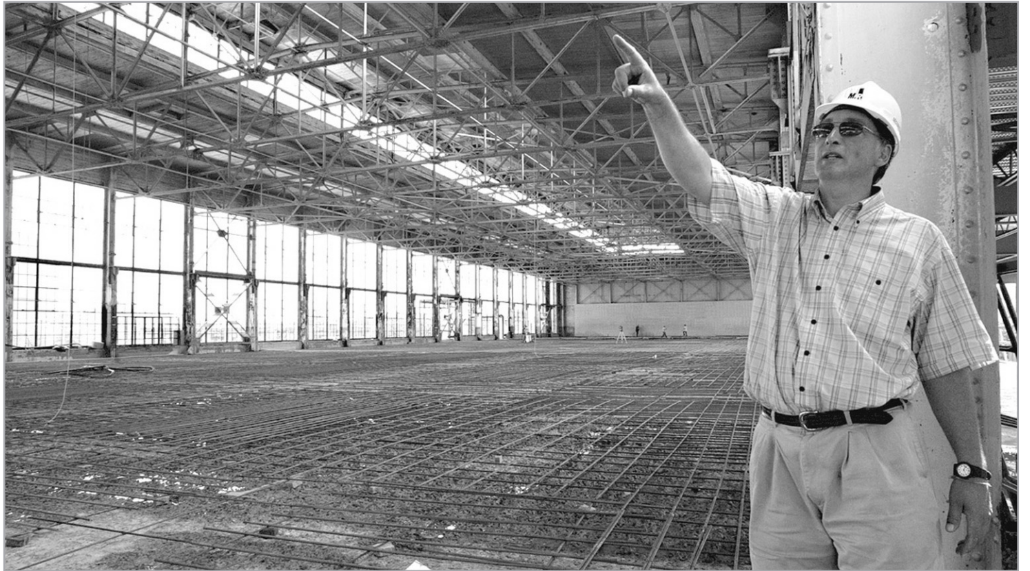
Richard Gravel pendant les travaux à l'édifice Connor
