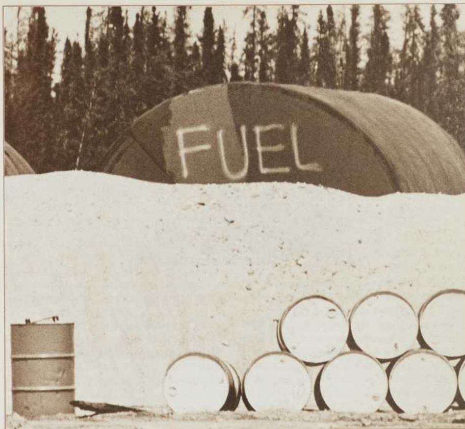
Camions et engins divers consomment d'énormes quantités de carburant à la baie James. Pour des raisons de sécurité et en même temps de protection de l'environnement, les parcs à carburant sont entourés d'une digue de protection.
