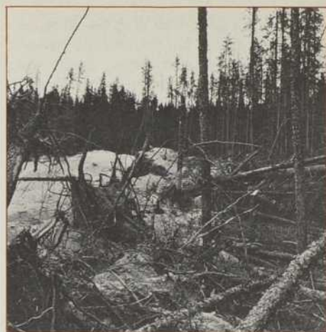
On aperçoit encore des bas-côtés de route en mauvais état, qui ne laissent aucune chance à la végétation pour qu'elle puisse repousser. Aujourd'hui, il faut d'abord couper les arbres au lieu de les bulldozer pêle-mêle avec les racines, la bonne terre végétale et le sable.
