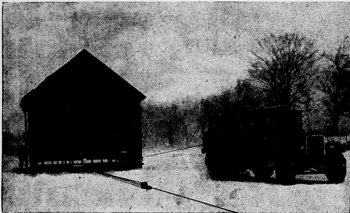
M. Wallace Warden de Huntingdon, ayant récemment acquis l'immeuble de Mlle Bruce sur l'Avenue Lorne, a décidé de le transporter près de sa résidence sur la rue Châteauguay. Rien de plus facile que le transport sur glace. Il suffit de placer des traîneaux sous l'édifice et "voilà ma galère" vers d'autres endroits plus propices.
