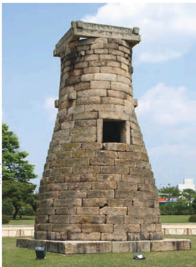
L'observatoire de Cheomseongdae et ses 362 morceaux de granit empilés sur neuf mètres de hauteur ont passé l'épreuve du temps.
