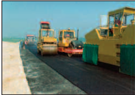
Figure 2 – Rouleaux vibrants et rouleau pneumatique
