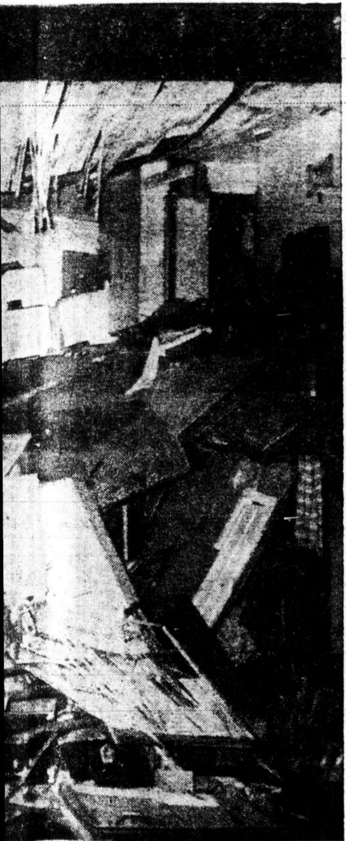
vents de 72 milles à l'heure ont soufflé sur Port-Arthur, Texas, détruisant la ruine et la destruction. On voit, ici, un bâtiment entièrement démoli sous la force du vent. (Fac-similé United Press — "Montréal-Matin")
