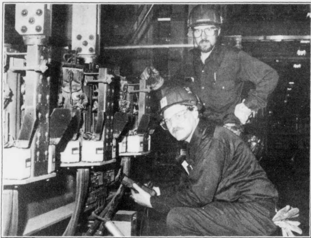
Les électriciens d'Énergie électrique Québec doivent inspecter les redresseurs avant que des modifications ne soient apportées. Sur ce cliché, Jacques Lajoie et André Lafrance.
