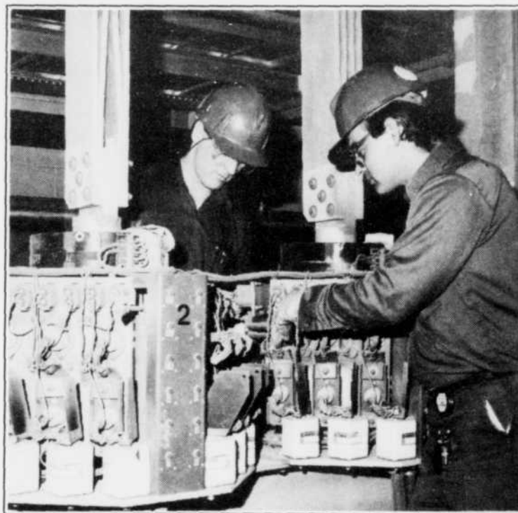
Gilles Tremblay et Chantal Lévesque s'affairent à réparer un des redresseurs en place au Complexe Jonquière. D'ici 1993, 50 appareils de ce type auront été rénovés.
