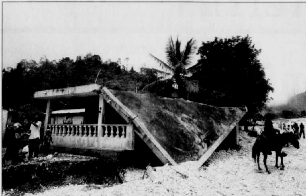
À Haïti, la ville la plus touchée a été Fonds Vêrette, au nord-est de la capitale Port-au-Prince, avec 158 morts, mais aussi 546 maisons détruites et 3 000 sinistrés
