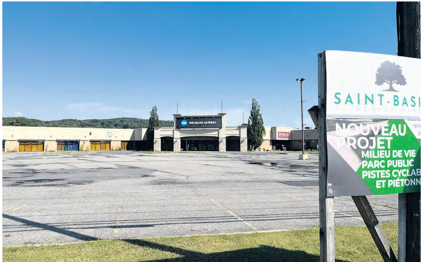
Le bâtiment de l'ancien commerce Maison Éthier serait sur le point d'être démolé. (Photo : Frank Jr Rodi)
