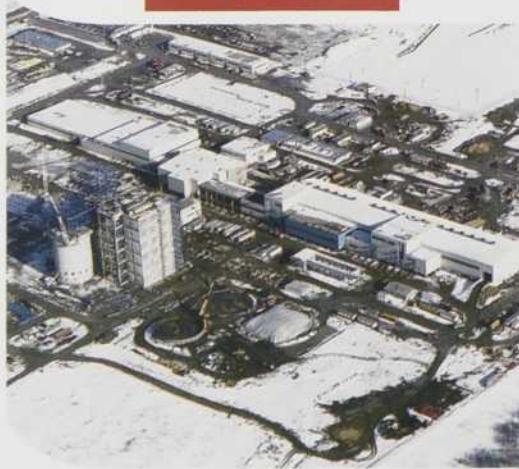
NORSK HYDRO Bécancour
