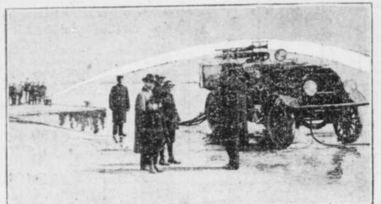
UN NOUVEAU APPAREIL PUISSANT POUR NOTRE DEPARTEMENT DES INCENDIES.—La nouvelle pompe automobile et voiture à boyaux combinée, lancée par un jet de 24 pouces avec une pression de 118 livres et un débit moyen de 1,242 gallons à la minute.—Cliché du photographe de la Presse.
