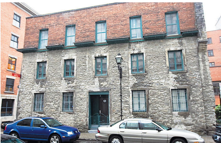
Ce grand édifice patrimonial a été divisé en huit condos en 1986.
