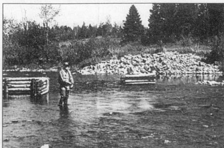
Les deux déflecteurs en bois que l'on aperçoit sur la rivière Nicolet servent à concentrer le courant, créant une fosse aquatique qu'exploite le pêcheur à l'œuvre avec ses mouches artificielles.
