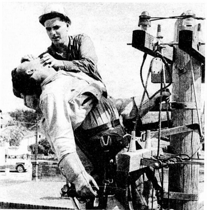
Le documentaire montre aussi un ouvrier électrocuté secouru par un camarade. Deux électriciens ont pu être sauvés ainsi.
