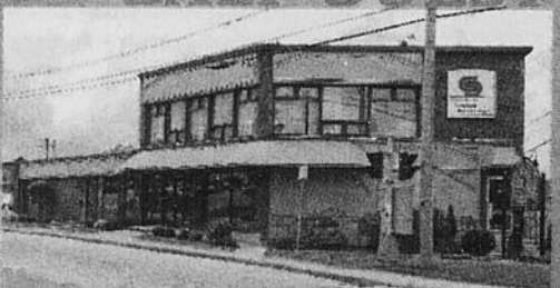
1011, rue Galt Ouest Quartier Ouest
