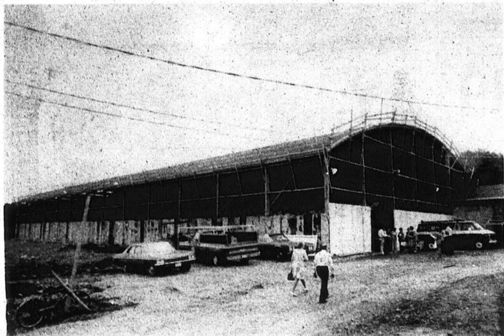
La construction est déjà avancée. Une fois les murs terminés, il restera à faire l'installation de la rampe pour que l'aréna soit utilisable au cours de la prochaine saison. On croit que tout sera prêt dès la fin d'août.
