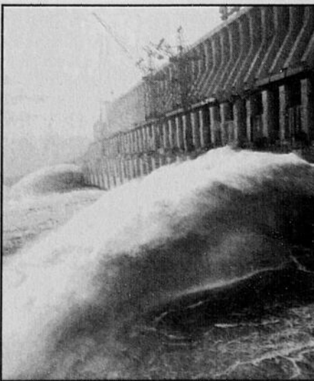
L'un des énormes évacuateurs de crues du barrage des Trois Gorges.
