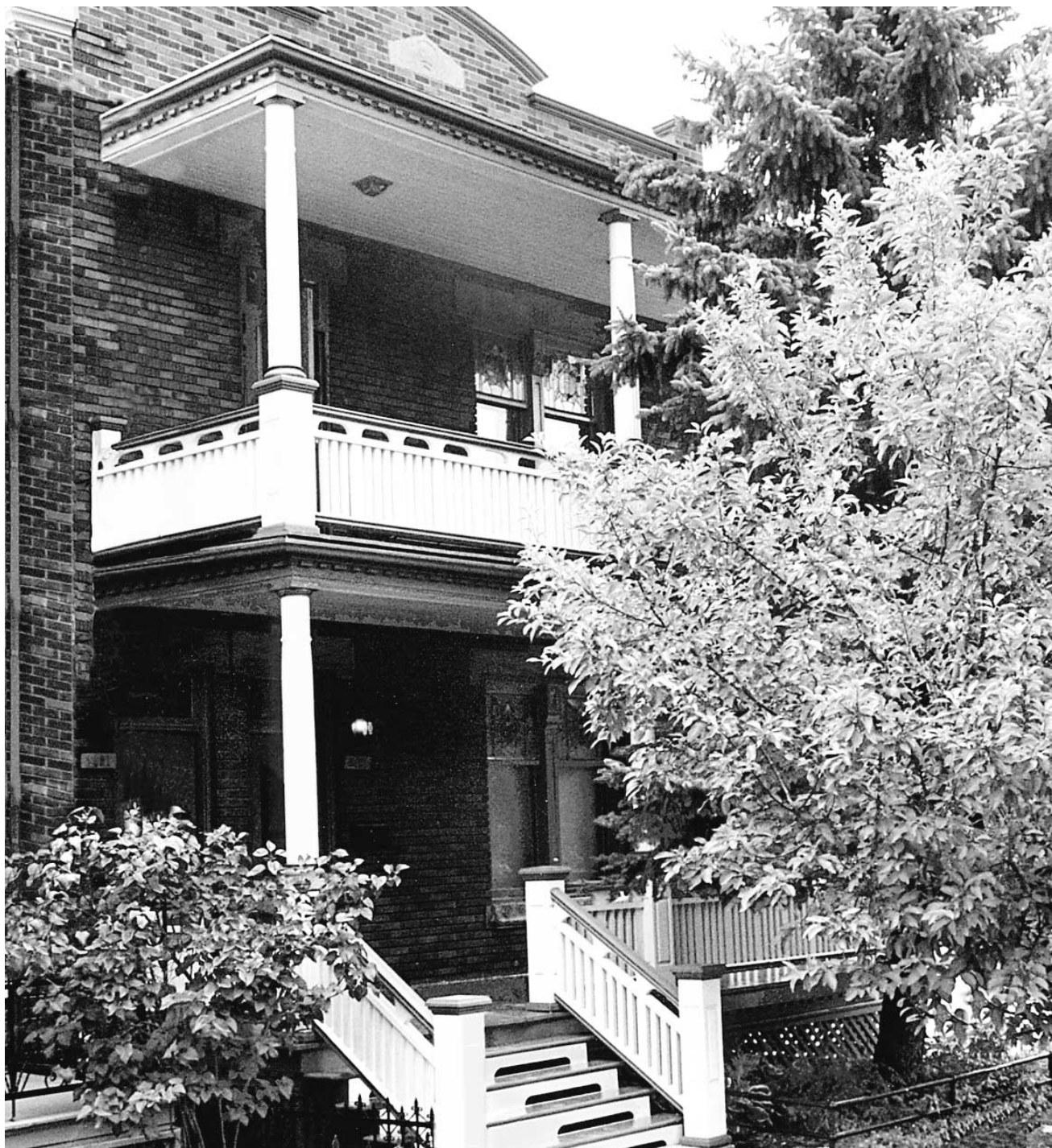
Le fer forgé a été remplacé par des balcons et des escaliers en bois semblables à ceux d'origine.
