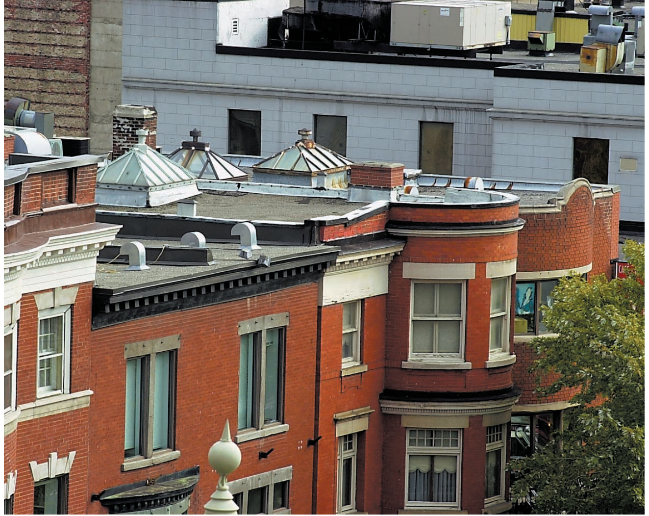
Les toits plats ou très légèrement pentus, avec système d'évacuation des eaux vers l'intérieur, ont connu une grande popularité au fil des ans, parce qu'ils sont particulièrement économiques.
