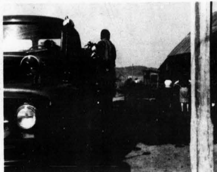
L'équipe de pompiers de Notre-Dame de la Paix a travaillé d'une façon remarquable afin d'empêcher les flammes de se propager aux bâtiments voisins. Nous remarquons M. Rémi Périard (conducteur de la pompe à incendie) vérifiant le réservoir
