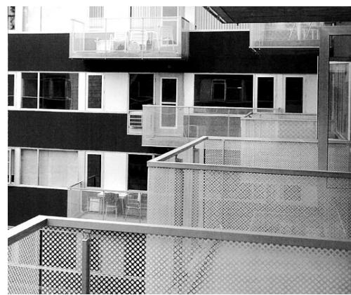
L'idée des balcons à pois a été inspirée par la géométrie du jardin conçu par Claude Cormier.
