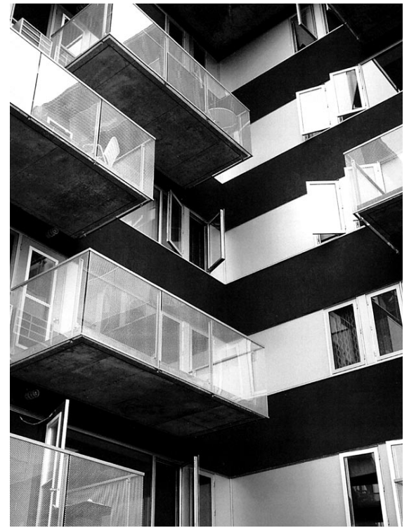
Les façades jouent sur l'alternance de bandeaux de vastes fenêtres et de stuc couleur anthracite.
