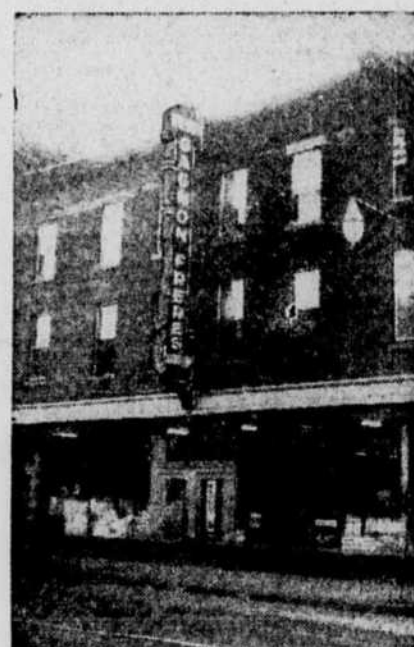
Meubles et accessoires électriques 2371 ouest, NOTRE-DAME
