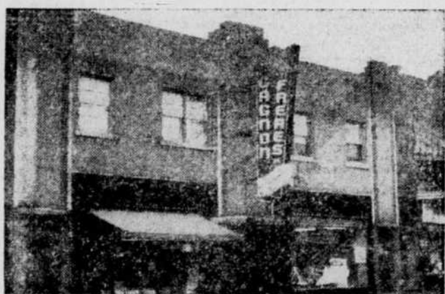
Meubles et accessoires électriques 6014 boul. MONK — VILLE EMARD
