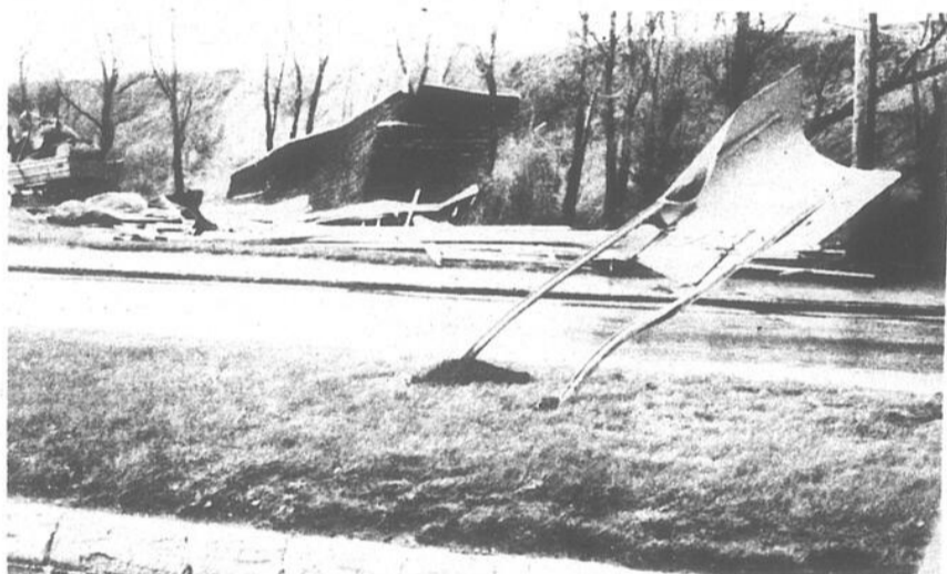
Un mur d'arbres a arrêté le vol plané de la toiture.
