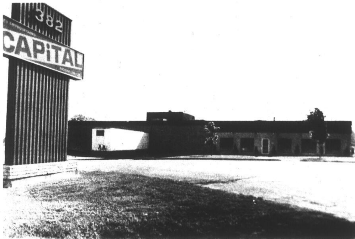
Dans quelques semaines, Tyson entreprendra d'importants travaux de réfection de la bâtisse de Capital. (Photo Jacques PAUL)
