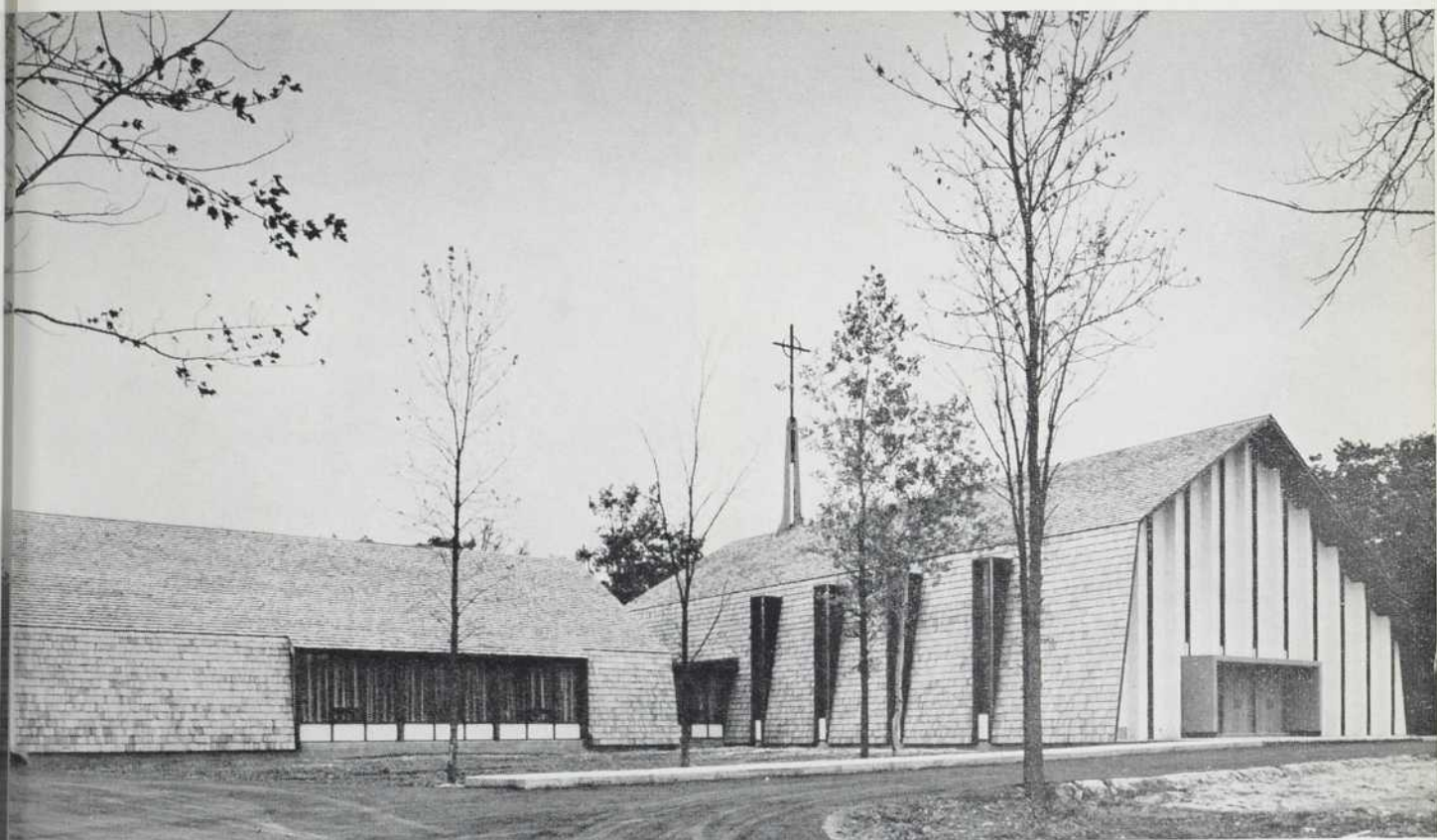
L'église St. Patrick of the Island, près de Montréal, semble se recueillir pieusement sous son revêtement de bardeaux de cèdre taillés à la main. Malgré un budget restreint, on a pu, grâce aux économies réalisées en utilisant du bois, ériger l'église et la salle paroissiale. Architecte: John W. Cook, de Montréal.
