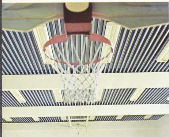
Economiques plafonds en acier avec canalisations à même.
