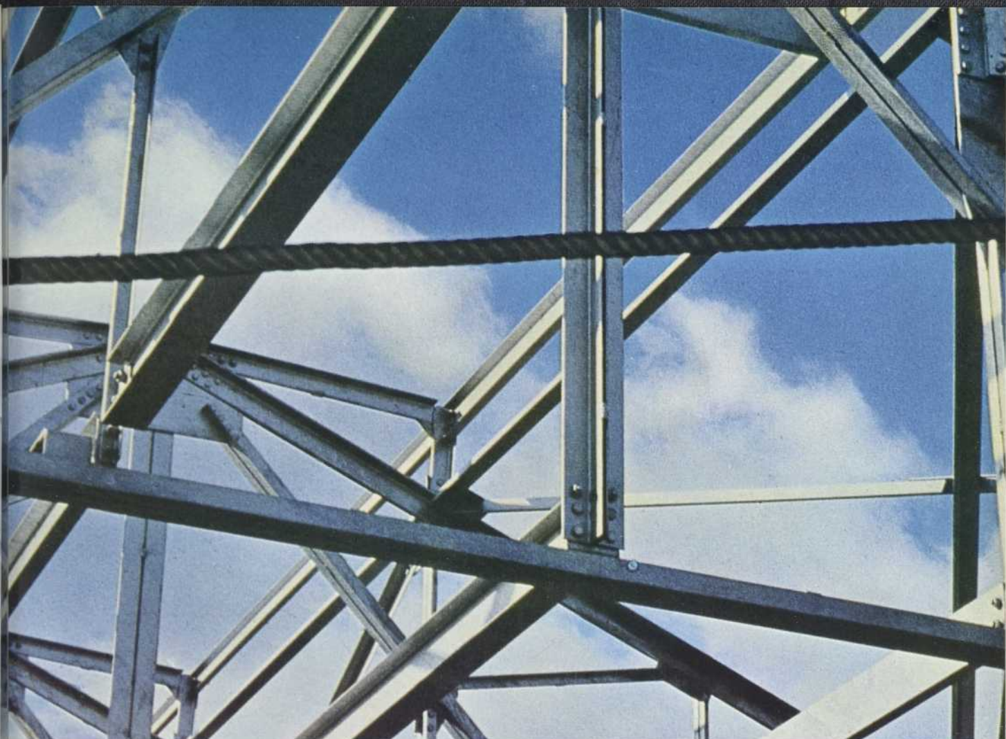
Acier de charpente zingué, au Centre de recherches sur les produits, à Sheridan Park, en Ontario.
