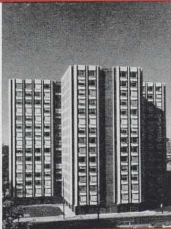
Centennial Towers, Ottawa Constructeurs: Campeau Con- struction Cie Ltée
