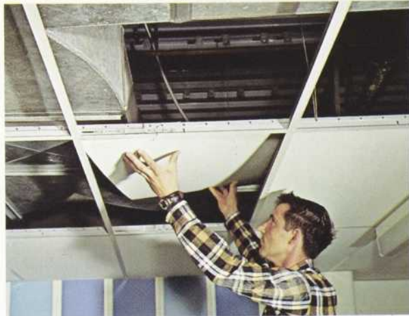
Robuste et légère, cette charpente en acier pour plafonds suspendus.
