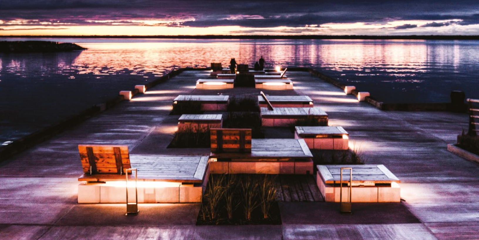
■ Réalisation du nouvel aménagement du brise-lames situé à l'embouchure de la rivière Rimouski.
