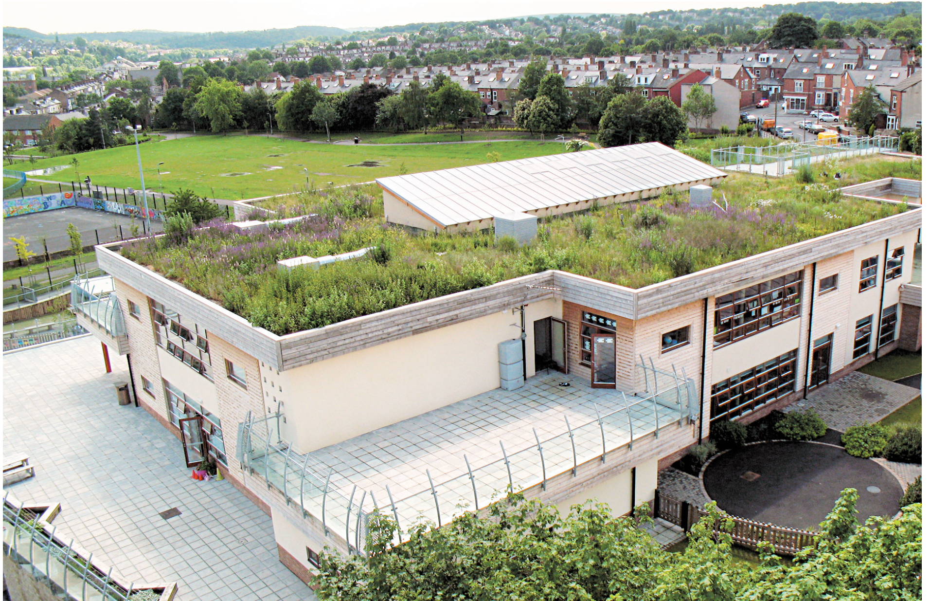
Toit vert de l'école primaire Sharrow, en Angleterre, réalisé par Nigel Dunnett. Ces installations permettent un contrôle du climat en milieu urbain.
