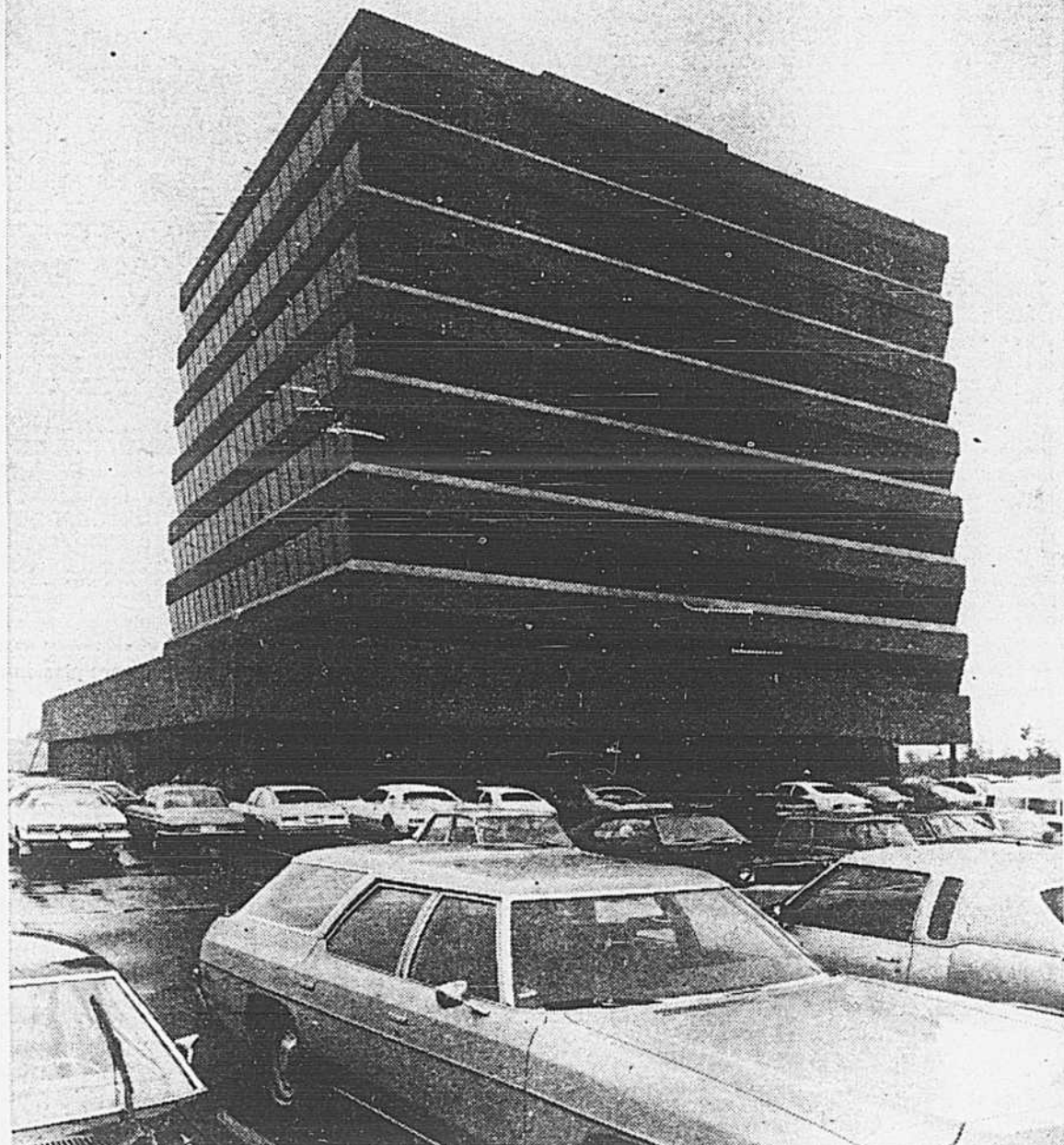
Le premier édifice à bureaux érigé à "Val des arbres" par Le Groupe Rock Ltée. Cet édifice devait avoir, initialement, six étages, mais les promoteurs l'ont construit sur huit étages. Trois autres immeubles du même genre doivent être érigés à "Val des arbres". Le deuxième sera mis en chantier au mois d'octobre.
