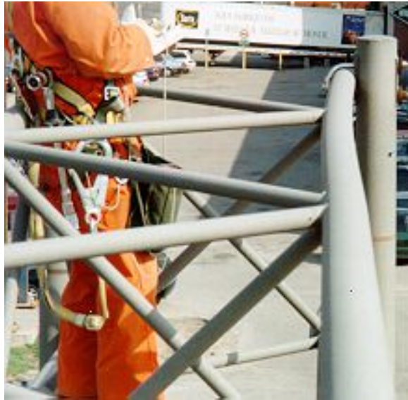
Photographie 5.6-5 Évaluation du comportement des longerons d'un support en treillis
