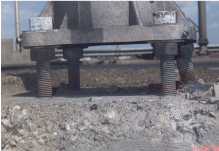
Photographie 5.4-5 Évaluation du comportement des tiges d'ancrage
