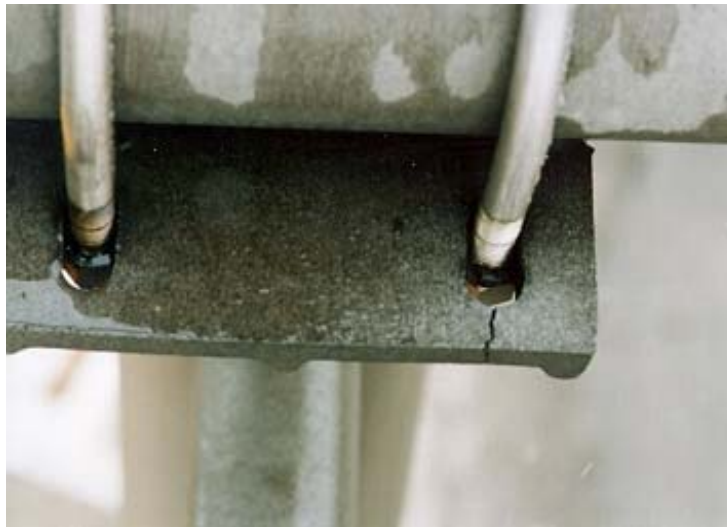
Photographie 5.9-2 Évaluation du comportement des éléments d'appui et d'assemblage du support horizontal
