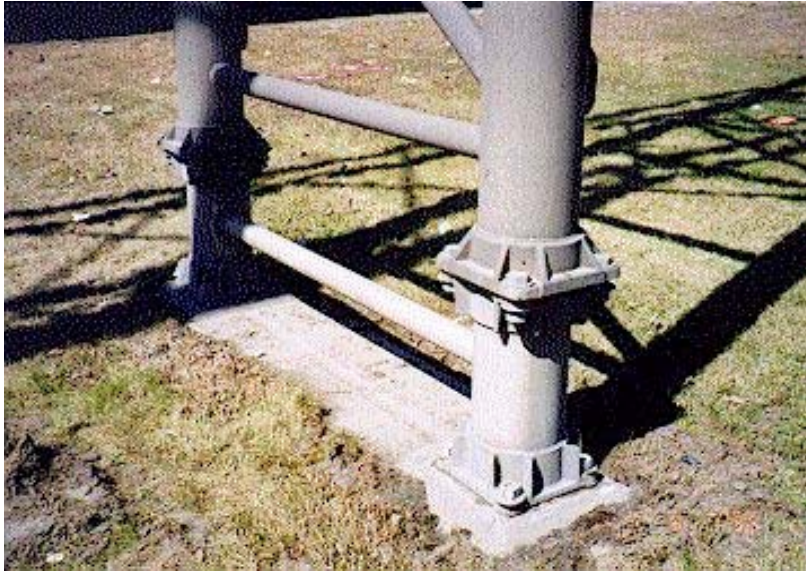
Photographie 5.5-8 Évaluation du comportement du support vertical
