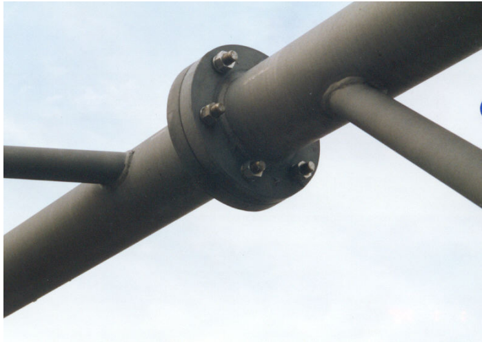
Photographie 5.6-11 Évaluation du comportement des membres secondaires d'un support en treillis
