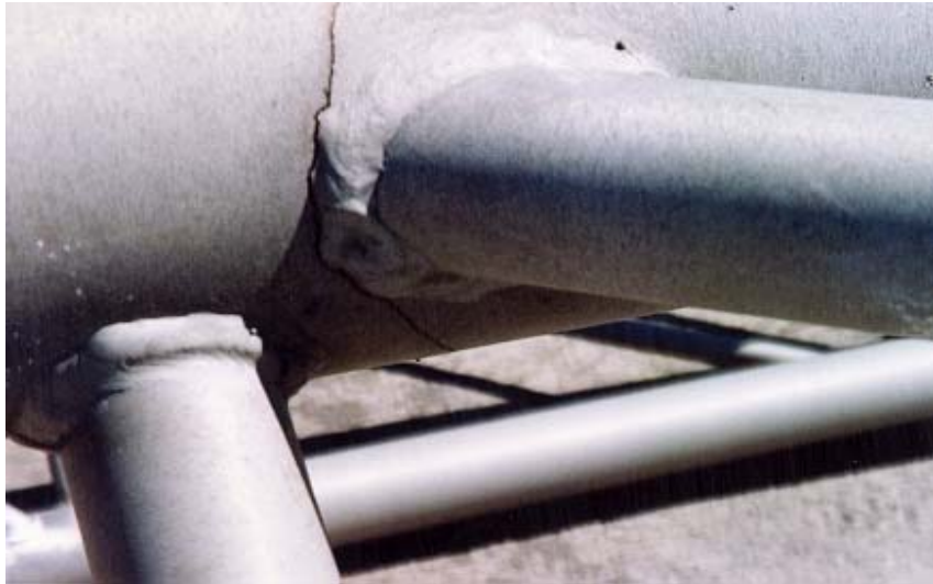
Photographie 5.6-1 Évaluation du comportement des longerons d'un support en treillis
