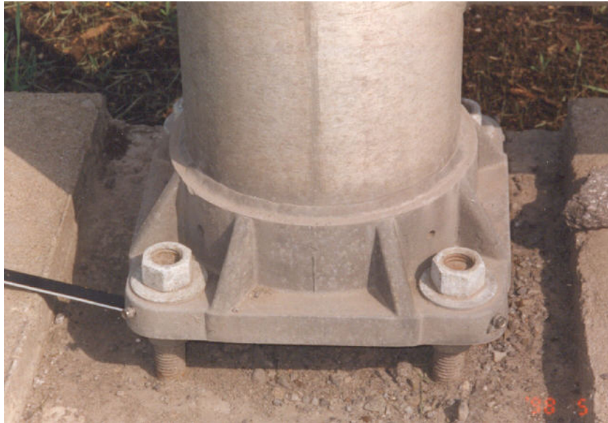
Photographie 5.4-11 Évaluation du comportement des tiges d'ancrage
