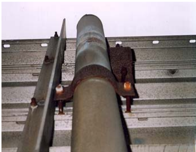
Photographie 5.10-6 Évaluation du comportement des attaches
