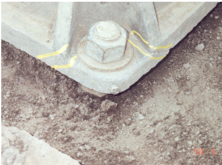
Photographie 5.4-14 Évaluation du comportement de la semelle d'ancrage
