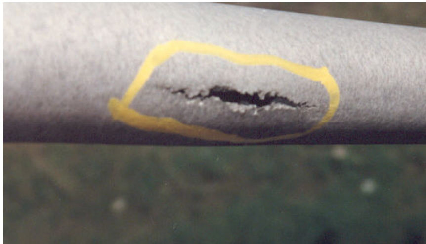
Photographie 5.5-6 Évaluation du comportement des membrures secondaires d'un support en treillis
