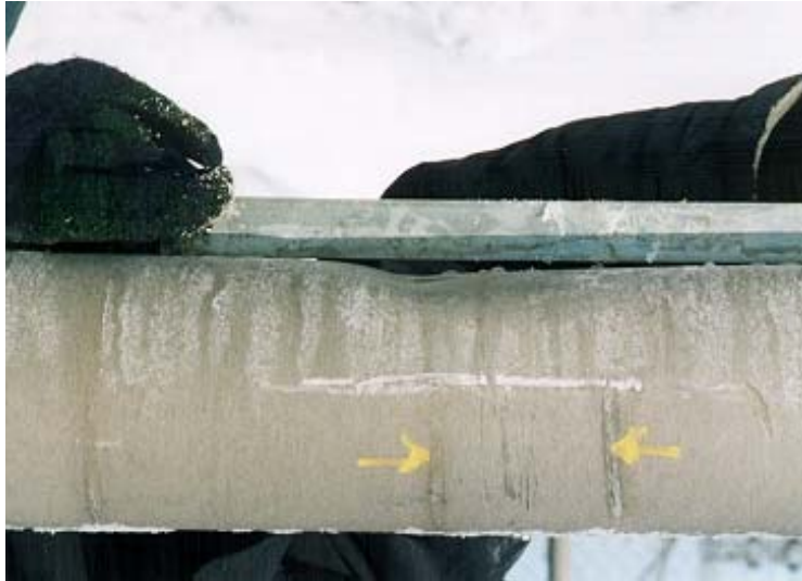
Photographie 5.6-4 Évaluation du comportement des longerons d'un support en treillis
