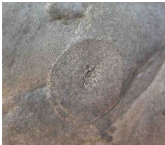
Photographie 5.7-1 Évaluation du comportement des assemblages soudés
