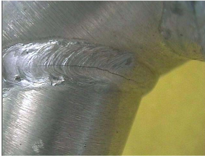
Photographie 5.7-3 Évaluation du comportement des assemblages soudés
