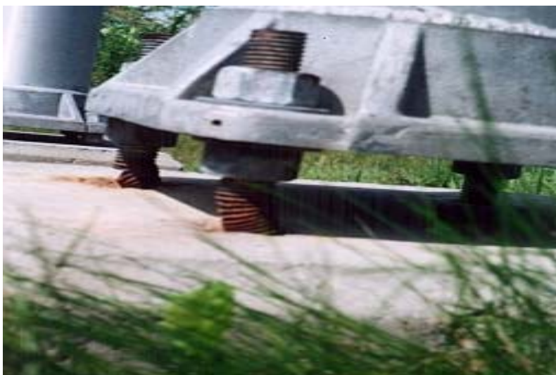
Photographie 5.4-6 Évaluation du comportement des tiges d'ancrage
