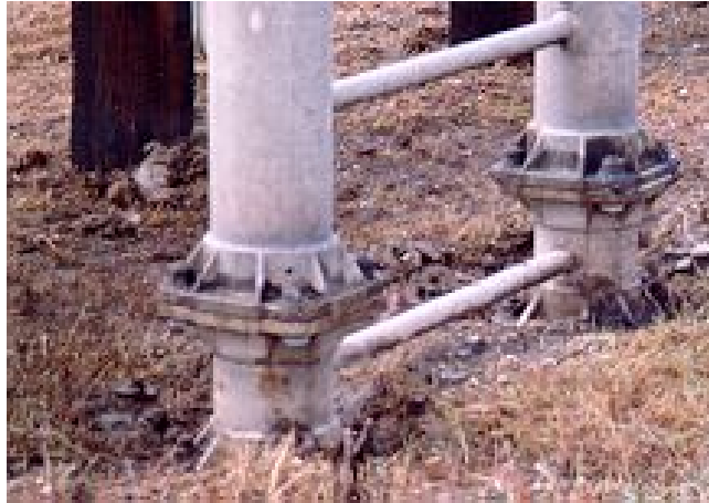
Photographie 5.3-9 Évaluation du comportement du remblai
