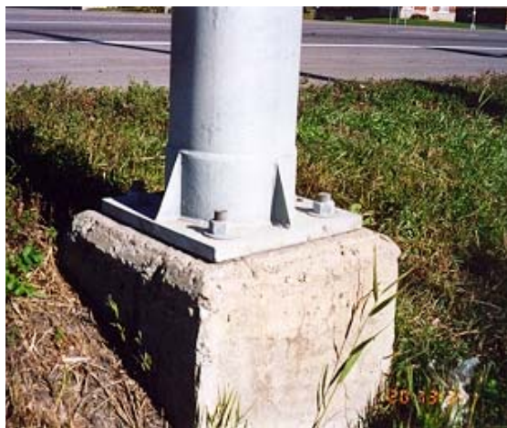
Photographie 5.3-8 Évaluation du comportement du remblai
