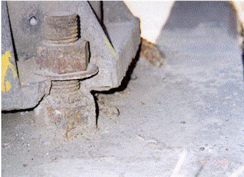
Photographie 5.4-13 Évaluation du comportement de la semelle d'ancrage
