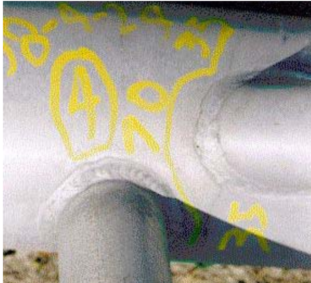
Photographie 5.6-2 Évaluation du comportement des longerons d'un support en treillis
