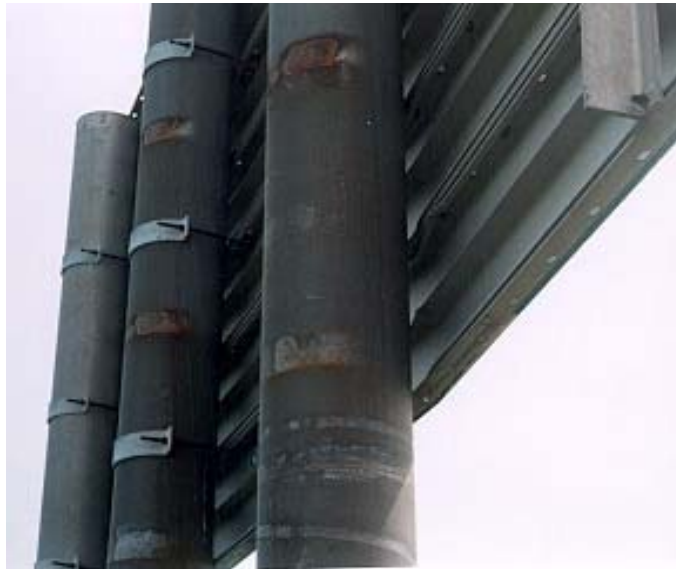
Photographie 5.10-5 Évaluation du comportement des attaches
