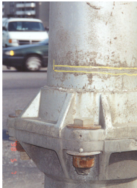
Photographie 5.5-5 Évaluation du comportement du poteau
