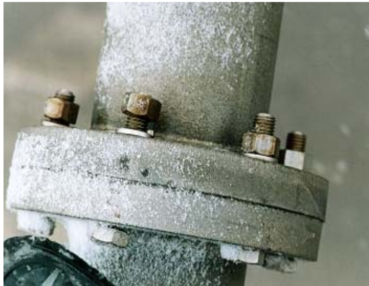
Photographie 5.8-2 Évaluation du comportement des assemblages boulonnés
