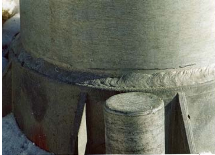
Photographie 5.5-2 Évaluation du comportement du poteau
