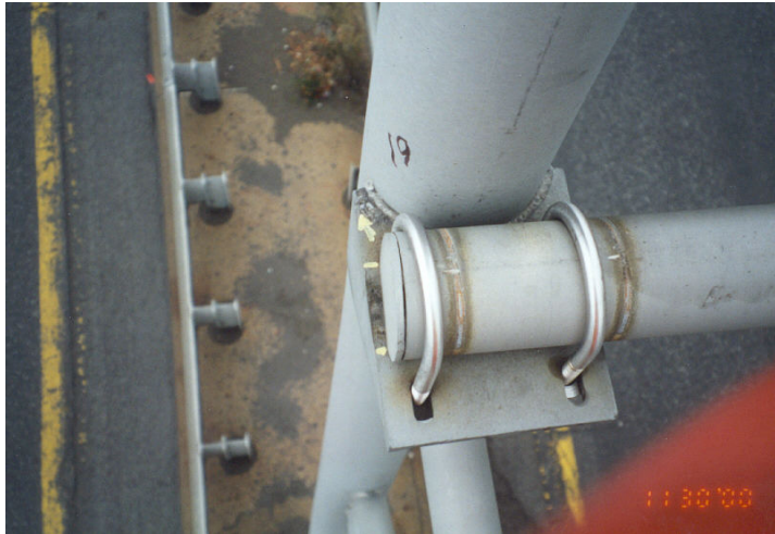
Photographie 5.9-3 Évaluation du comportement des éléments d'appui et d'assemblage du support horizontal
