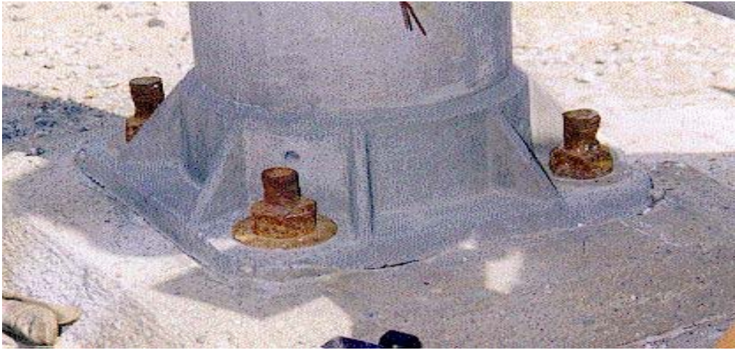
Photographie 5.4-3 Évaluation du comportement des tiges d'ancrage
