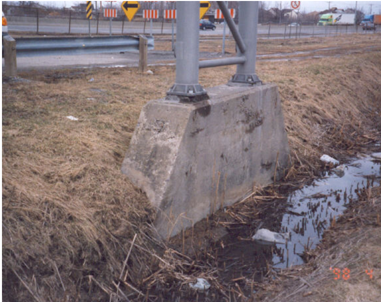
Photographie 5.3-1 Évaluation du comportement de la fondation du massif
