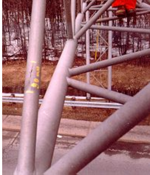
Photographie 5.6-9 Évaluation du comportement des membrures secondaires d'un support en treillis
