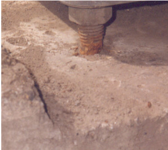
Photographie 5.4-1 Évaluation du comportement des tiges d'ancrage
