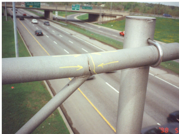
Photographie 5.6-6 Évaluation du comportement des longerons d'un support en treillis
