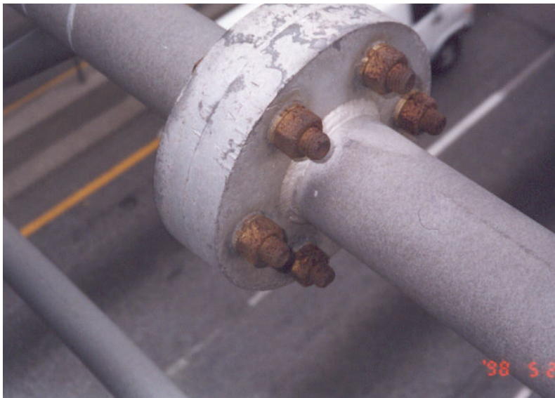
Photographie 5.8-4 Évaluation du comportement des assemblages boulonnés
