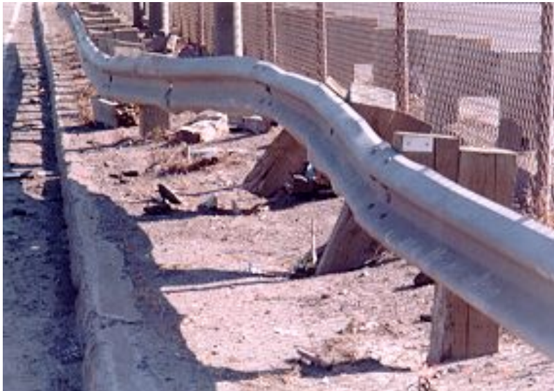
Photographie 5.11-1 Évaluation du comportement de la glissière de sécurité
