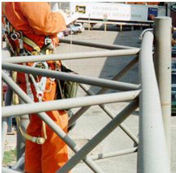
Photographie 5.9-4 Évaluation du comportement des éléments d'appui et d'assemblage du support horizontal
