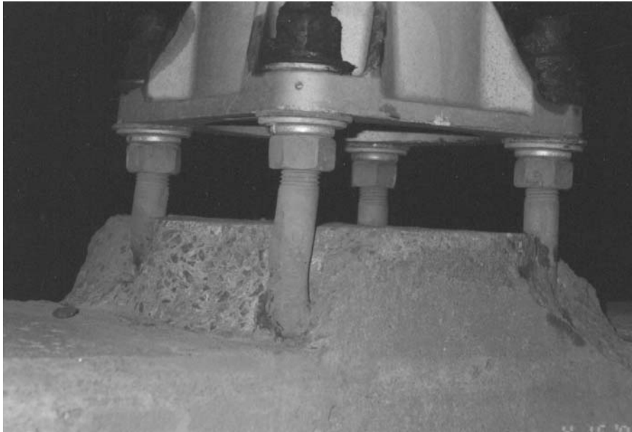
Photographie 5.4-10 Évaluation du comportement des tiges d'ancrage
