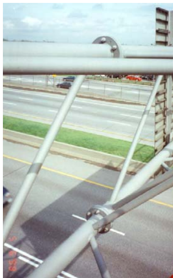
Photographie 5.6-10 Évaluation du comportement des membres secondaires d'un support en treillis
