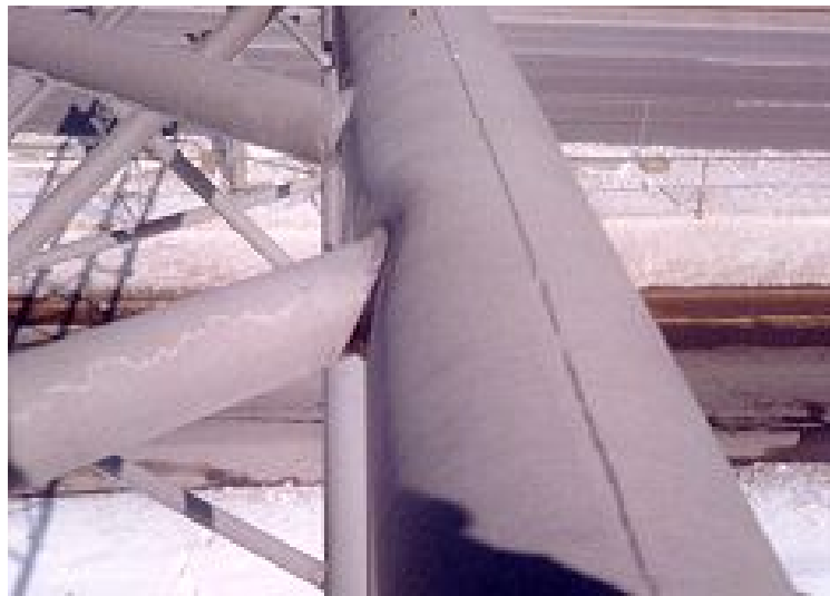
Photographie 5.6-3 Évaluation du comportement des longerons d'un support en treillis
