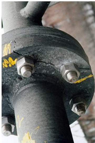
Photographie 5.8-1 Évaluation du comportement des assemblages boulonnés
