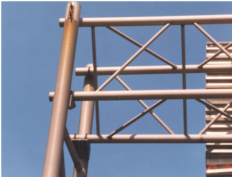
Photographie 5.6-12 Évaluation du comportement des membres secondaires d'un support en treillis
