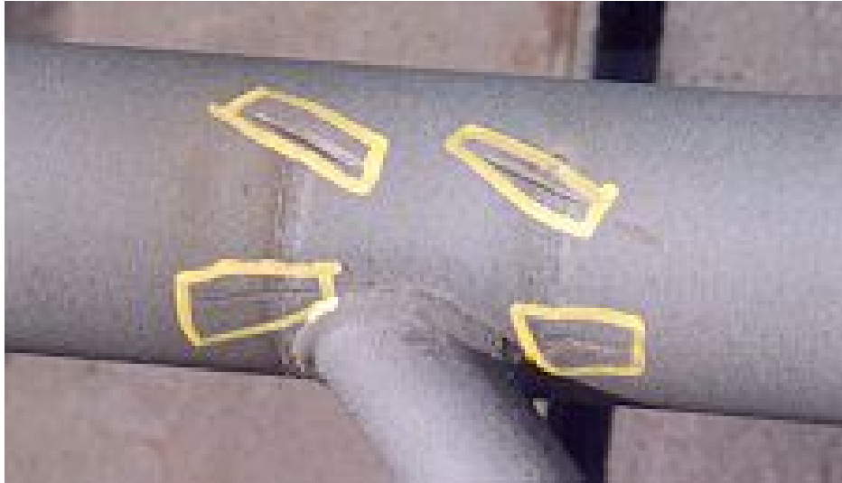
Photographie 5.6-7 Évaluation du comportement des longerons d'un support en treillis
