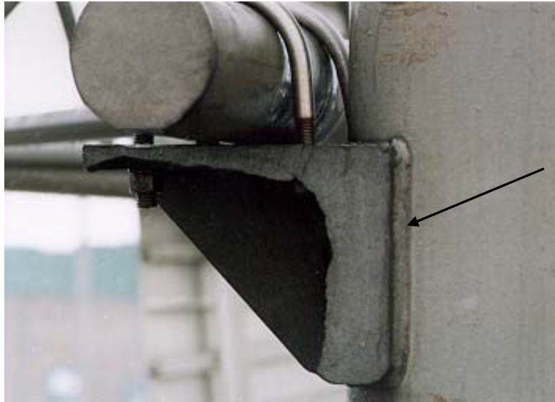
Photographie 5.7-5 Évaluation du comportement des assemblages soudés
