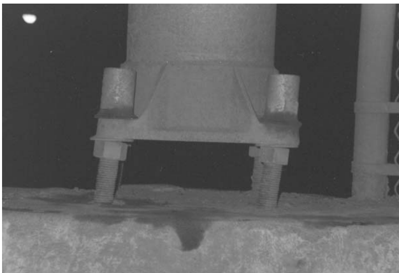
Photographie 5.4-8 Évaluation du comportement des tiges d'ancrage
