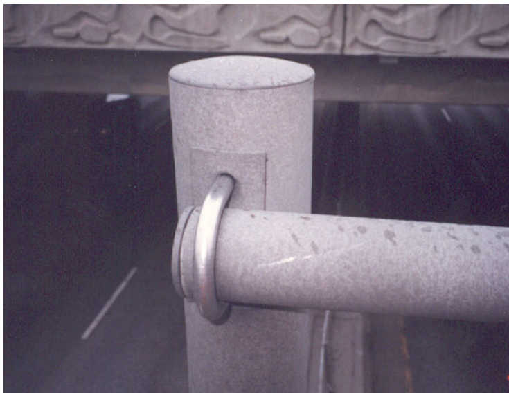
Photographie 5.6-14 Évaluation du comportement des longerons d'un support en treillis
