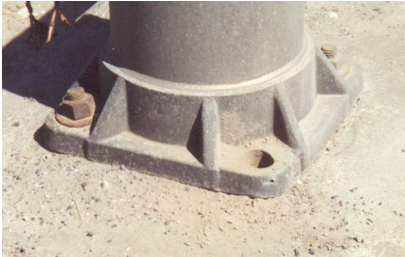
Photographie 5.4-7 Évaluation du comportement des tiges d'ancrage
