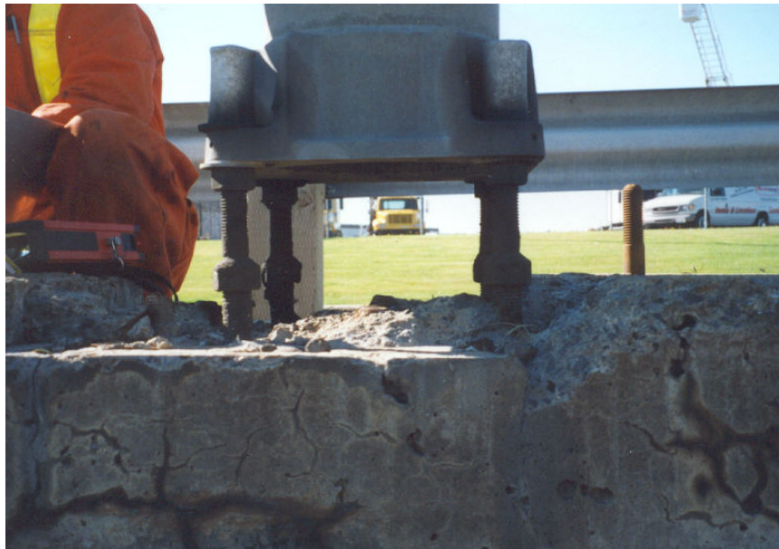
Photographie 5.4-9 Évaluation du comportement des tiges d'ancrage
