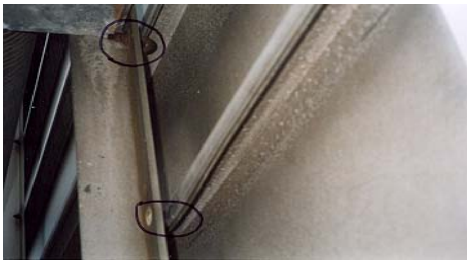
Photographie 5.10-3 Évaluation du comportement de la pièce en T d'une structure de signalisation aérienne
