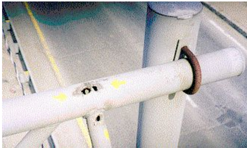
Photographie 5.6-8 Évaluation du comportement des longerons d'un support en treillis
