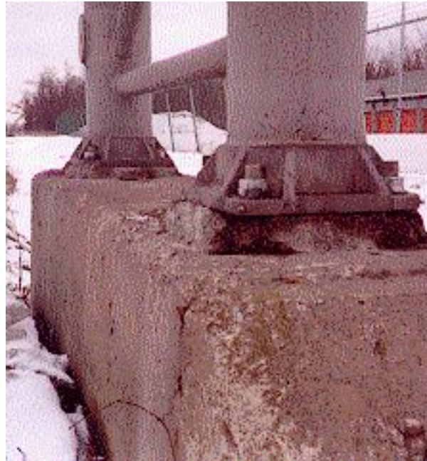
Photographie 5.4-12 Évaluation du comportement des tiges d'ancrage
