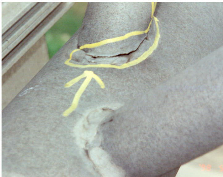
Photographie 5.7-4 Évaluation du comportement des assemblages soudés
