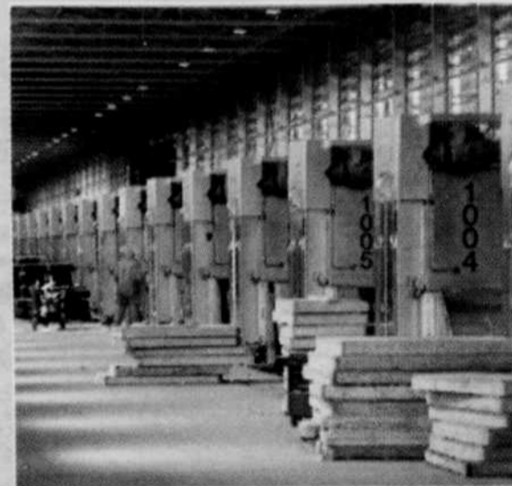
La mise en place des superstructures au-dessus des cuves progresse dans les bâtiments de un kilomètre des salles de cuves.
