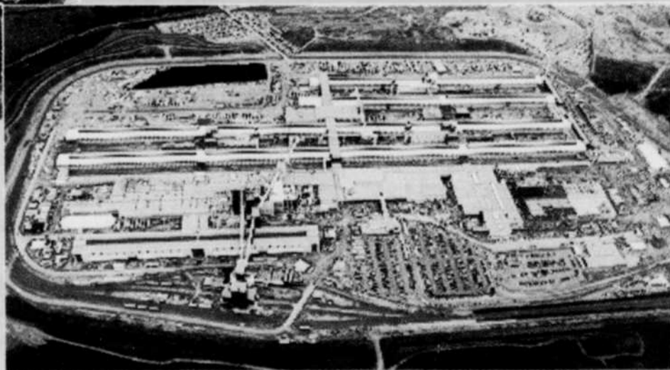
Vue générale du chantier dans l'axe nord-sud.
