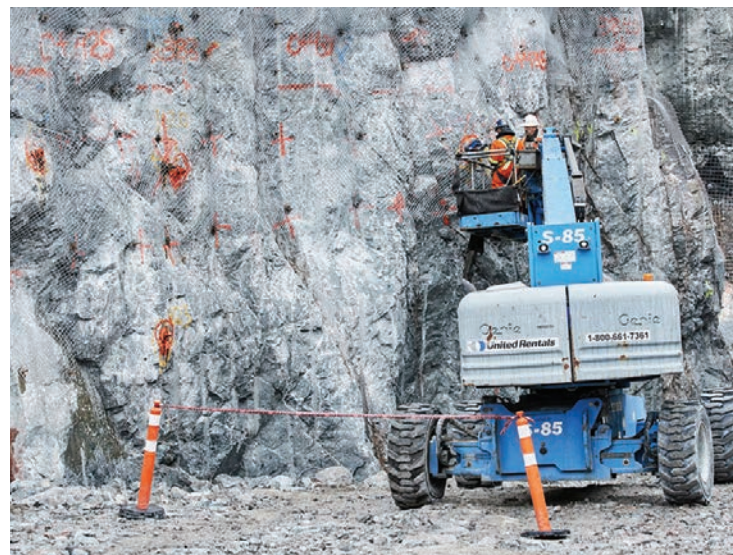
Des travailleurs solidifient une paroi rocheuse en septembre 2017 au chantier de la Romaine-4. (Photo: Hydro-Québec)
